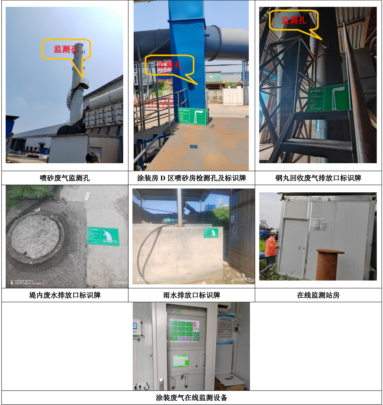
图 4.2-2 项目排污口规范化及在线监测装置图
