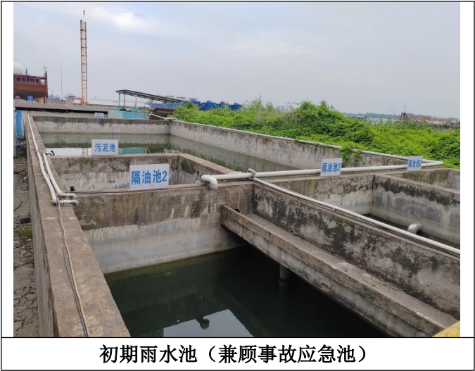
图 4.1-3 厂区初期雨水收集系统图
