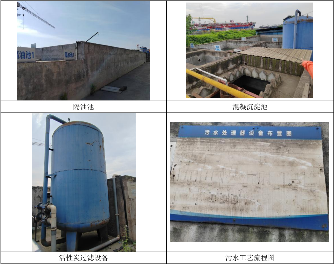
图 4.1-2 项目废水收集处理措施图
