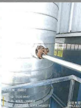
01 DA001 熔炼废气排气筒
