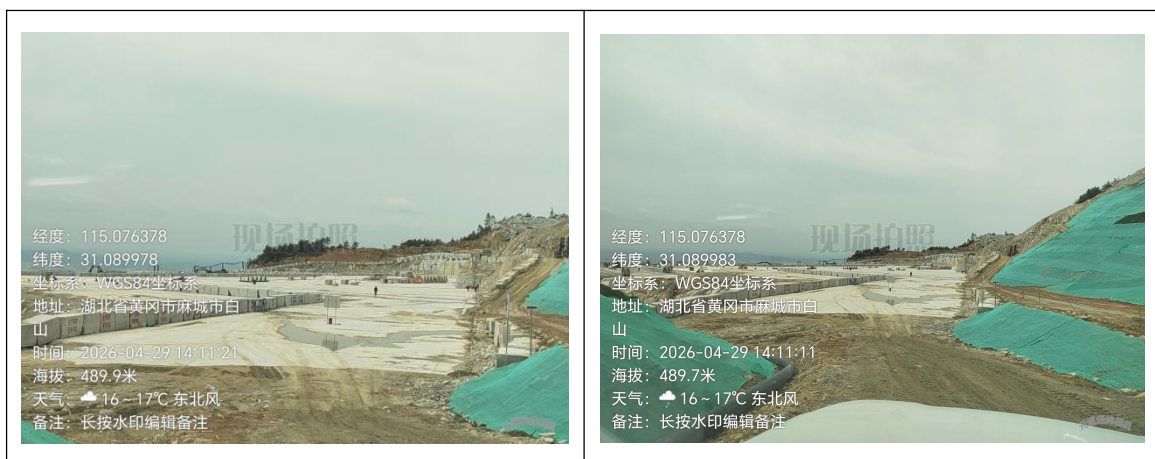
图4-10 项目矿区边坡复绿图
