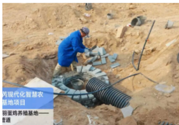
施工期沉砂池施工
