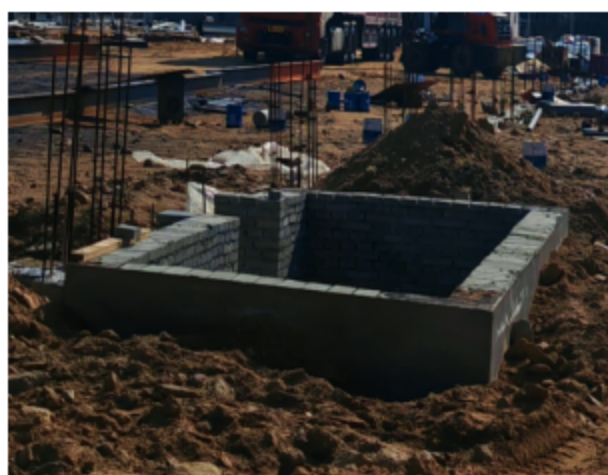
初期雨水收集池
