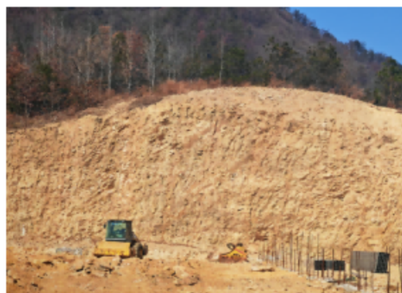
施工期边坡修整施工
