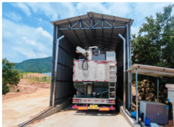
进出口消毒设施
