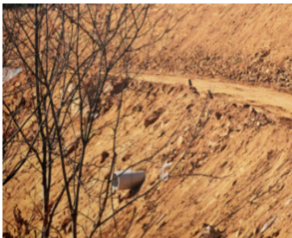
边坡排水措施
