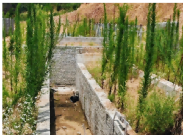
生产区雨水管网
