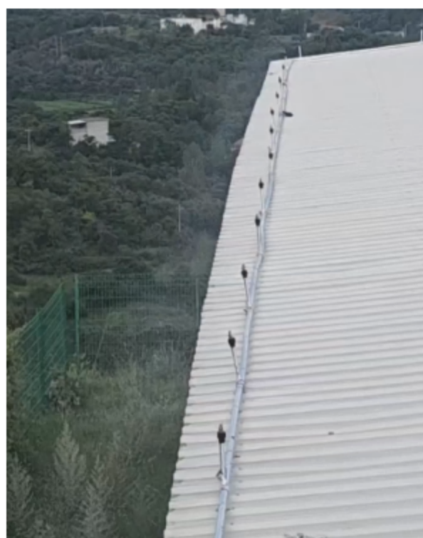
鸡粪风干通风口喷淋生物除臭装置
