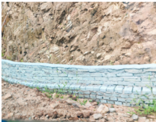
进出道路两侧挡土措施
