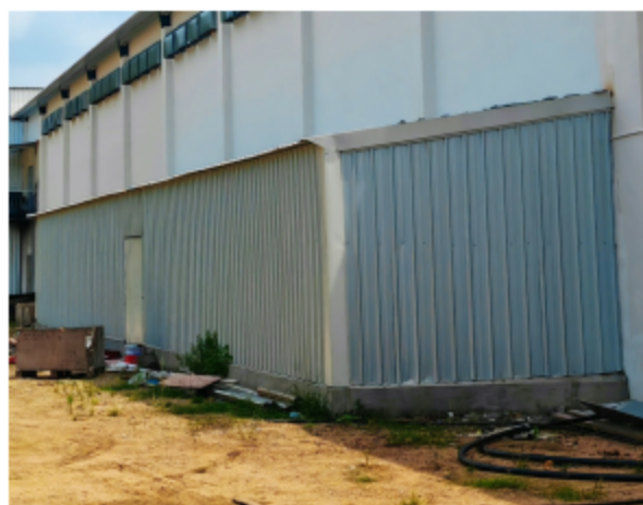
一般固废暂存间
