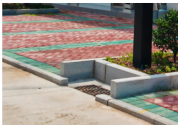
场内排水沟（暗沟）
