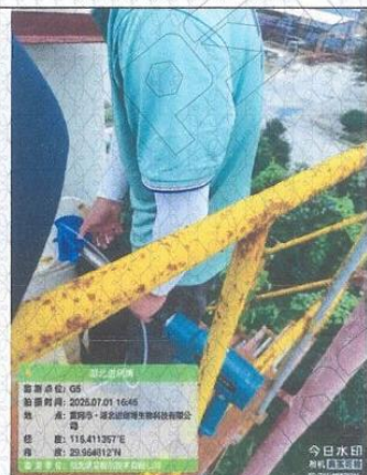
有组织废气采样照片
