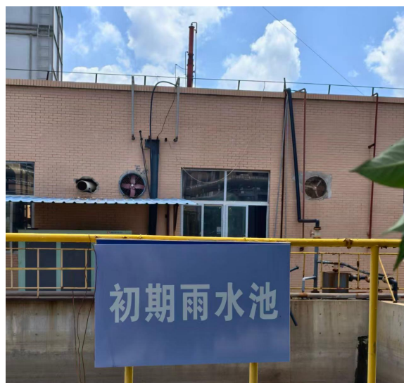
初期雨水收集池
