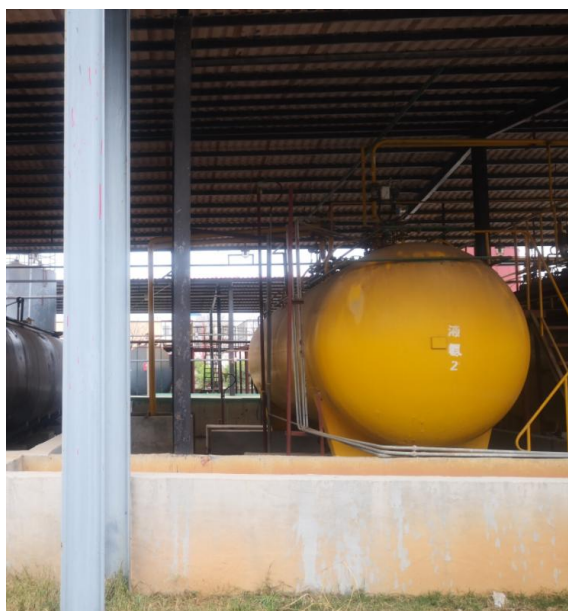
液氨储罐区围堰
