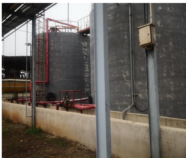
原料罐区围堰
