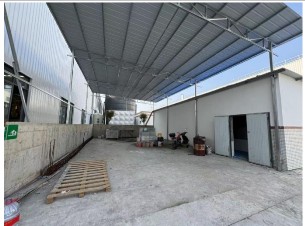
一般工业固体废物暂存间
