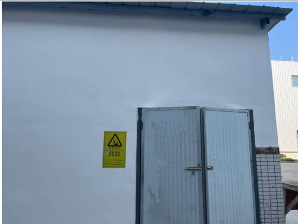
危险废物暂存间
