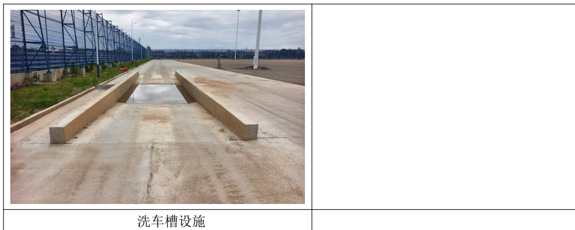
图 5-4 项目运营期机械设备冲洗废水、车辆冲洗废水除尘废水污染防治图
