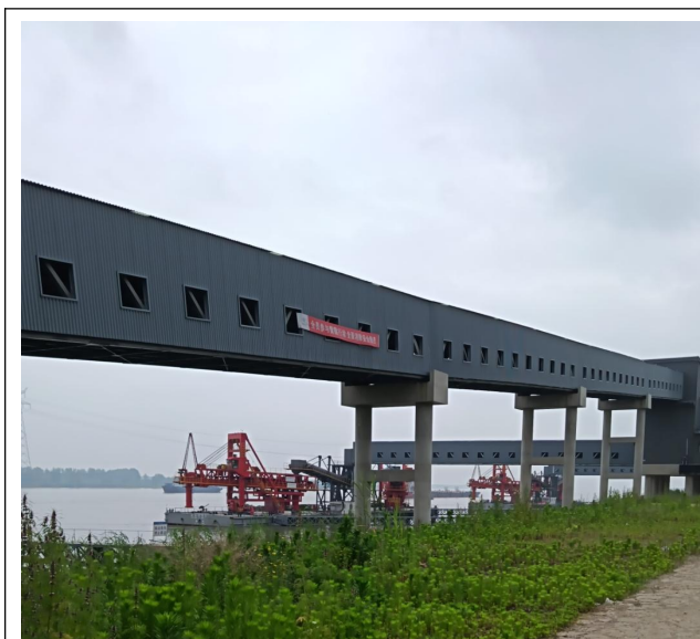
物料输送封闭廊道
