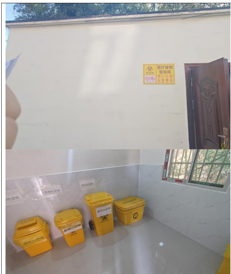
医疗废物暂存间
