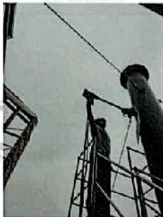
苯甲酸铵装置废气 排气筒出口
