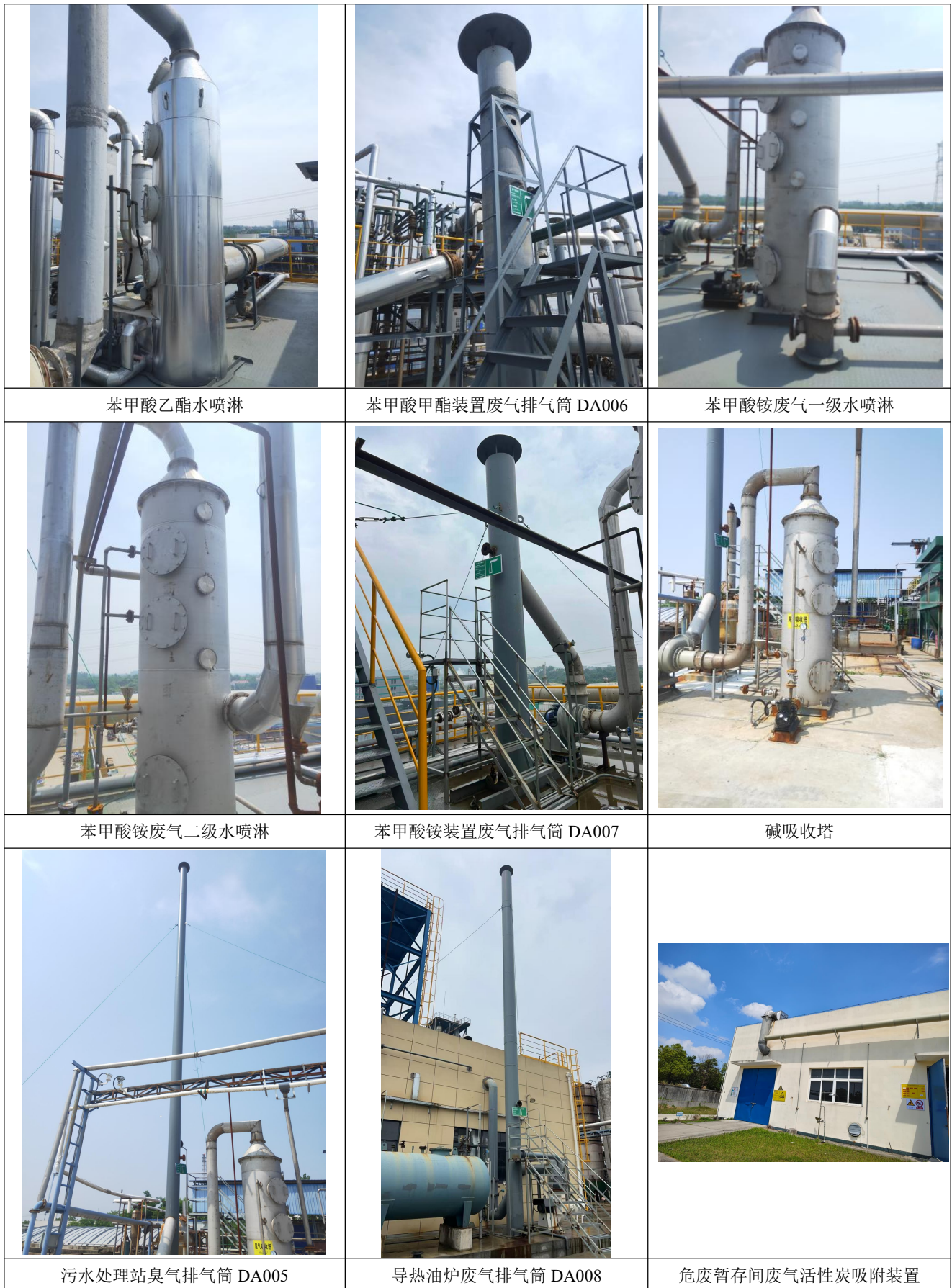
图 4.1-5 项目废气收集处理措施图
