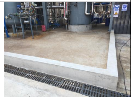
精化装置区围堰
