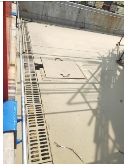
罐区收集沟和收集池
