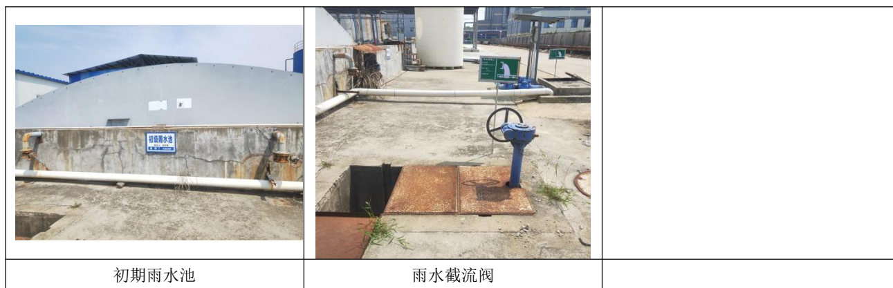
图 4.1-3 厂区初期雨水收集系统图
