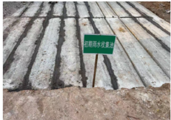
初期雨水收集池建成
