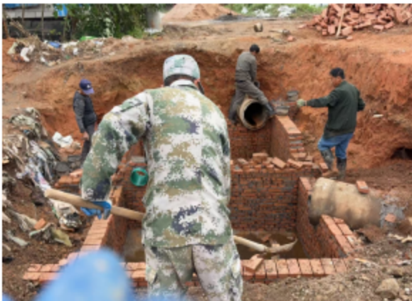
初期雨水收集池施工阶段
