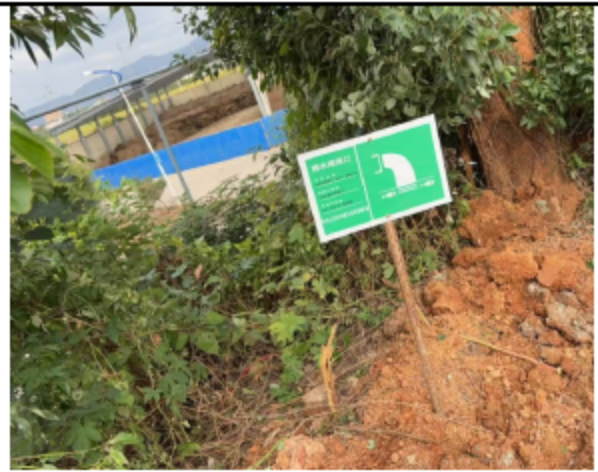
雨水排放口标识牌
