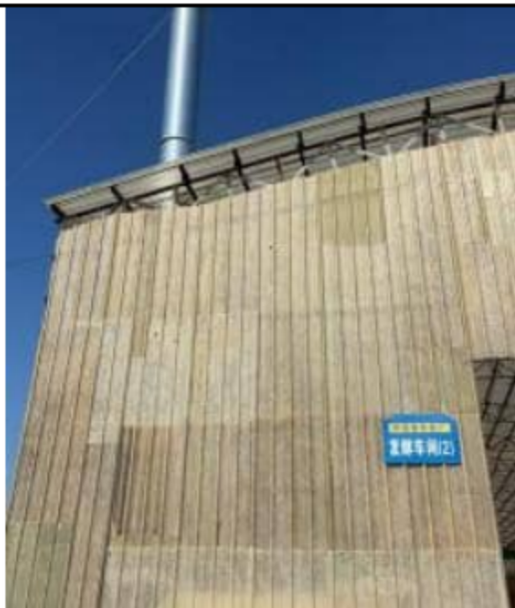
封闭发酵车间
