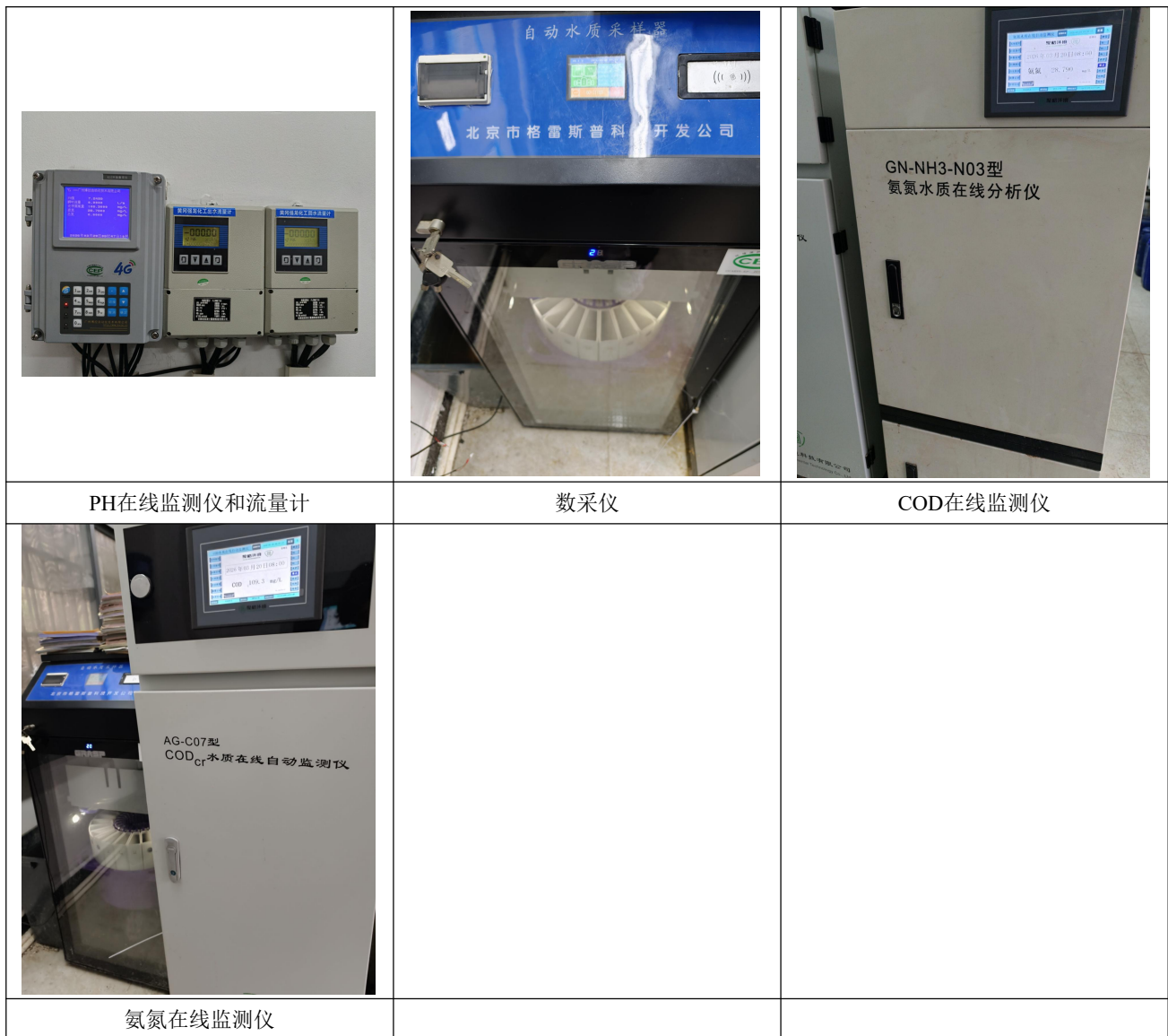
图 4.1-2 项目废水收集处理措施图
