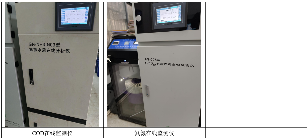
图 4.2-2 排污口规范化设置和在线监测装置图
