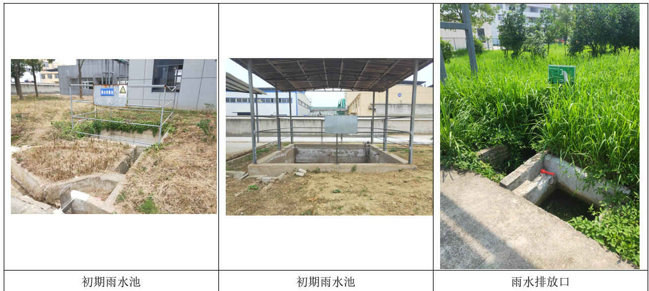
图 4.1-3 厂区初期雨水收集系统图
