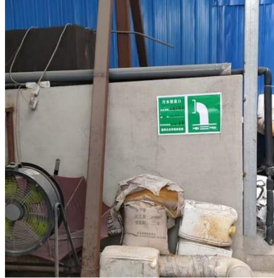
污水排放口标识牌
