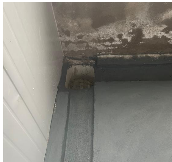
危废间内部防渗及导流沟、收集池
