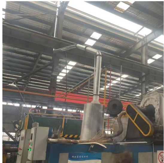
加热炉废气排气筒
