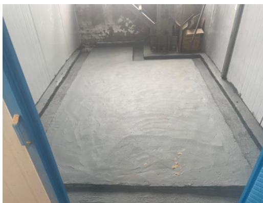
危废间内部防渗及导流沟、收集池
