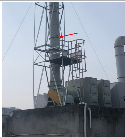
DA004 排气筒监测孔及采样平台
