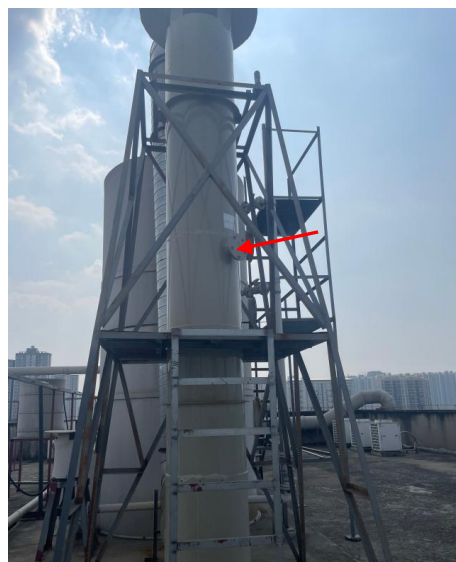
DA004 排气筒监测孔及采样平台
