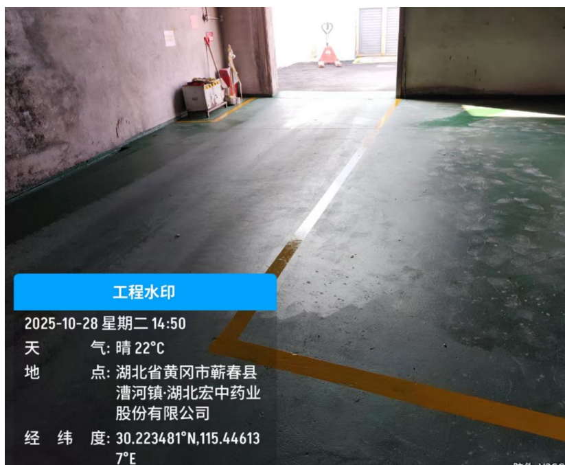
危废间地面防渗
