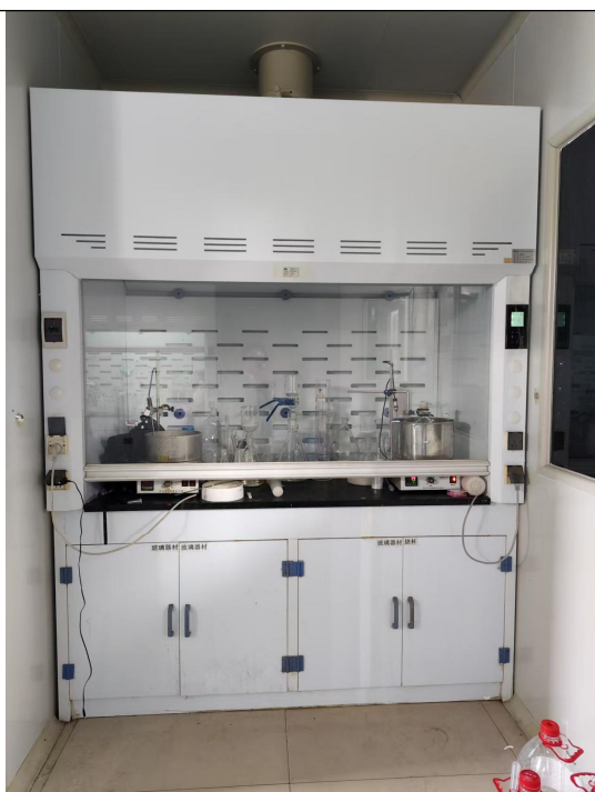
化验室废气收集通风橱
