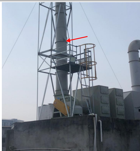
DA004 排气筒监测孔及采样平台
