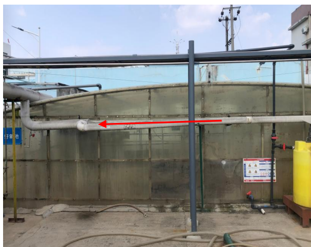
好氧池密闭加盖以及废气收集管道
