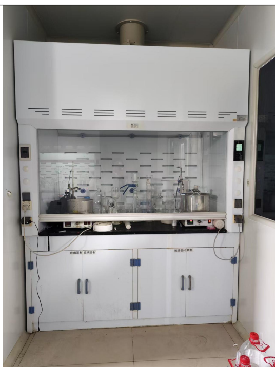
化验室废气收集通风橱
