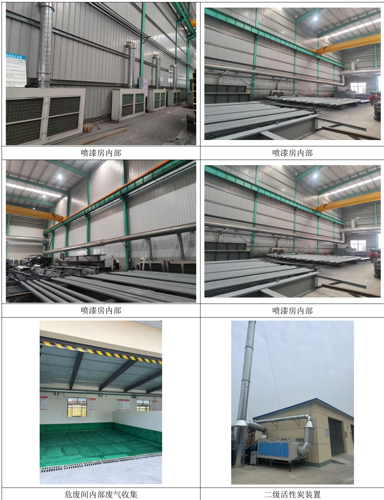
图 4.1-4 项目废气收集处理措施图
