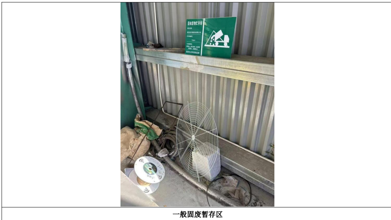
图 4.1-5 项目固废贮存设施图
