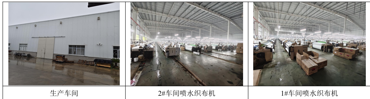
图 2-1 项目现场情况图片
