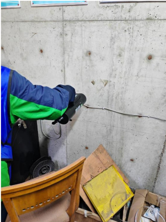
探伤室北侧工作间屏蔽墙外 30cm 处
