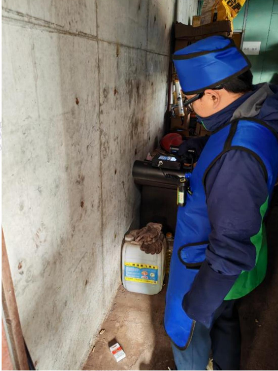
探伤室东侧屏蔽墙
