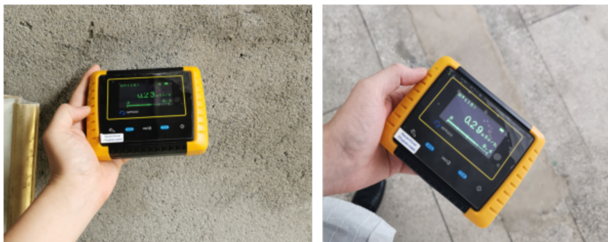
图 6-2 现场巡检照片
