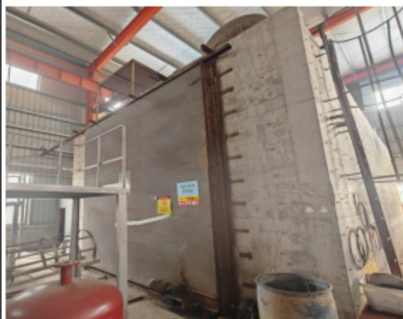
探伤室建设情况
