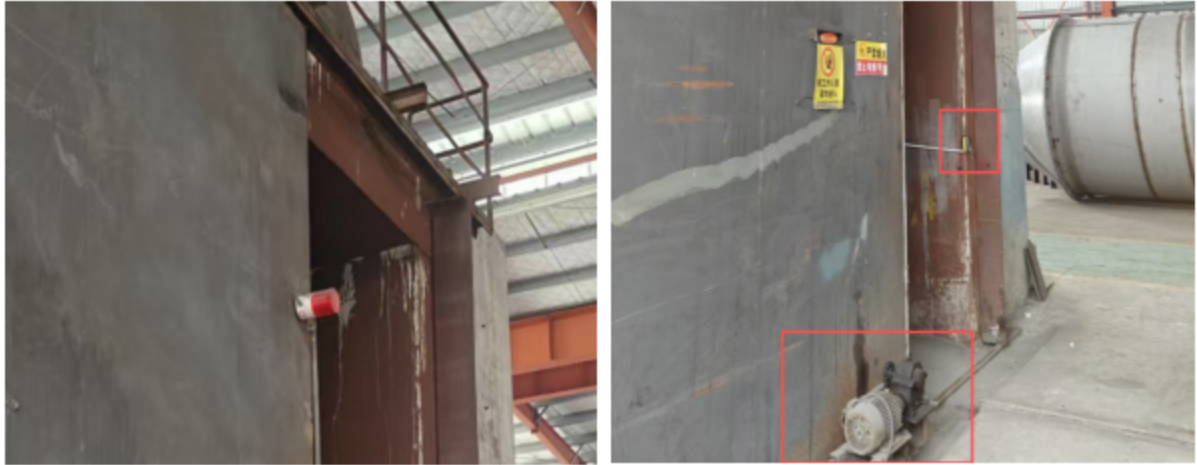
图 3-4 门灯连锁装置
