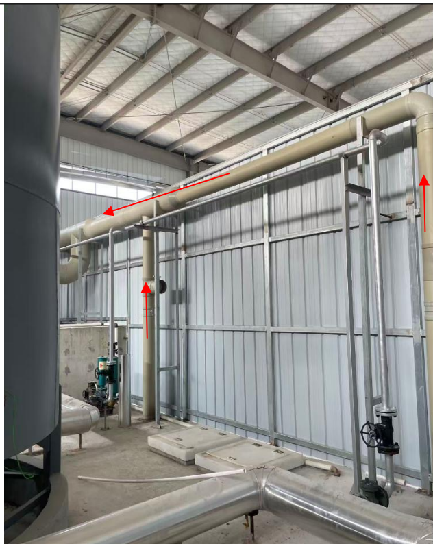
油水分离池废气（废白土车间）
