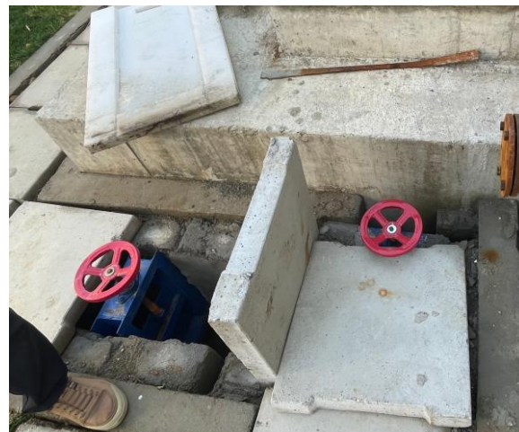
雨水切断阀
