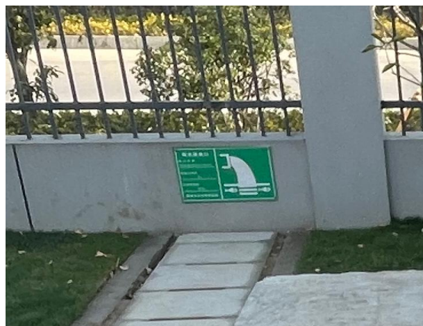
雨水排放口及标识牌
