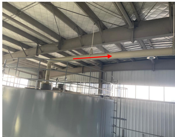
沉淀池废气收集管道
