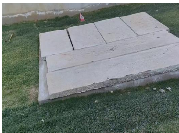
罐区雨水缓冲池 (3m 3 )
