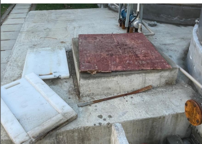
初期雨水收集池
