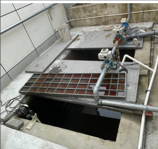
废水外排明渠
