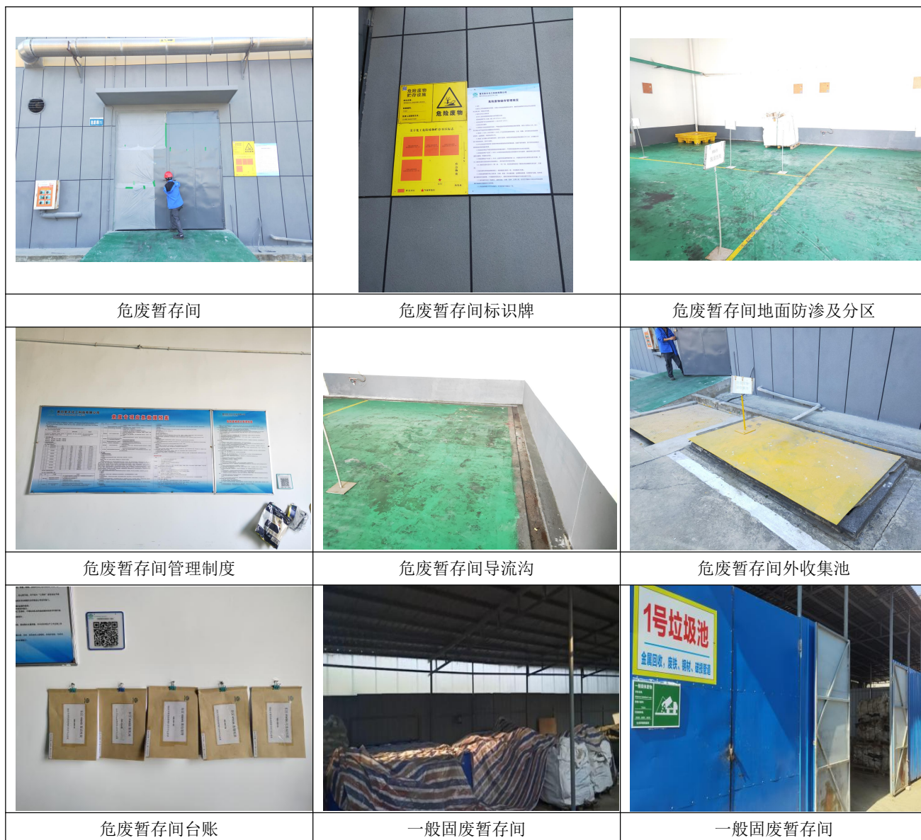
图 4.1-6 厂区危废暂存间及一般固废暂存间建设图
