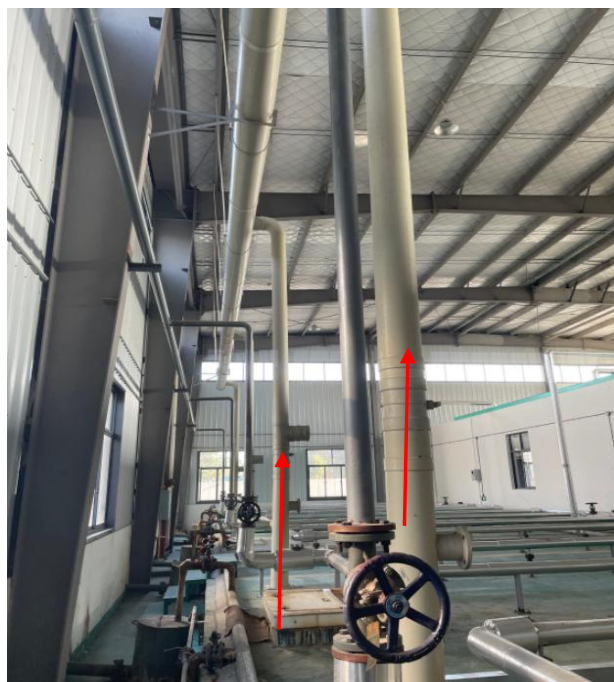
酸化池废气收集管道
