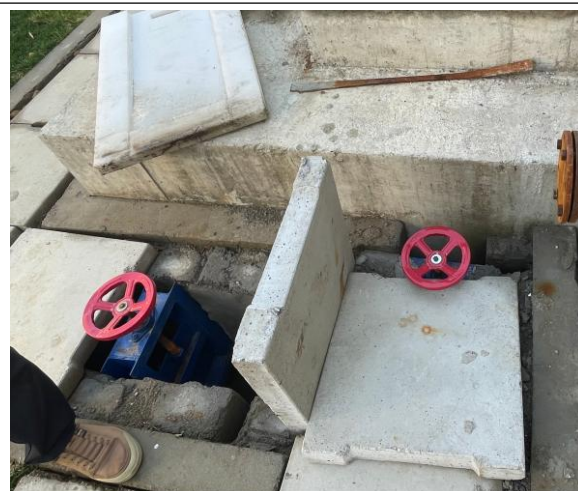
雨水切断阀
