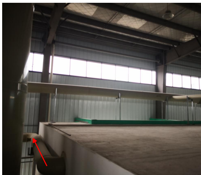
隔油池和调节池废水收集管道
