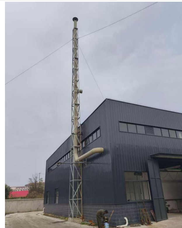
综合废气排气筒（15m）
