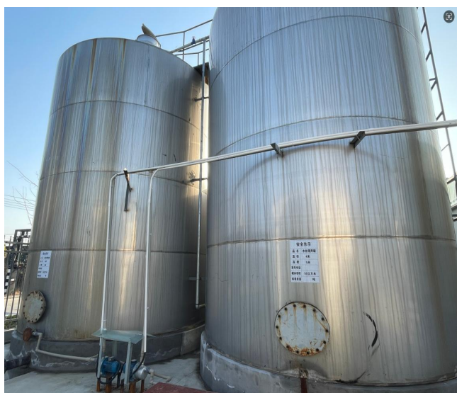
废水冷却罐
