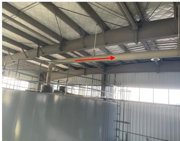
沉淀池废气收集管道
