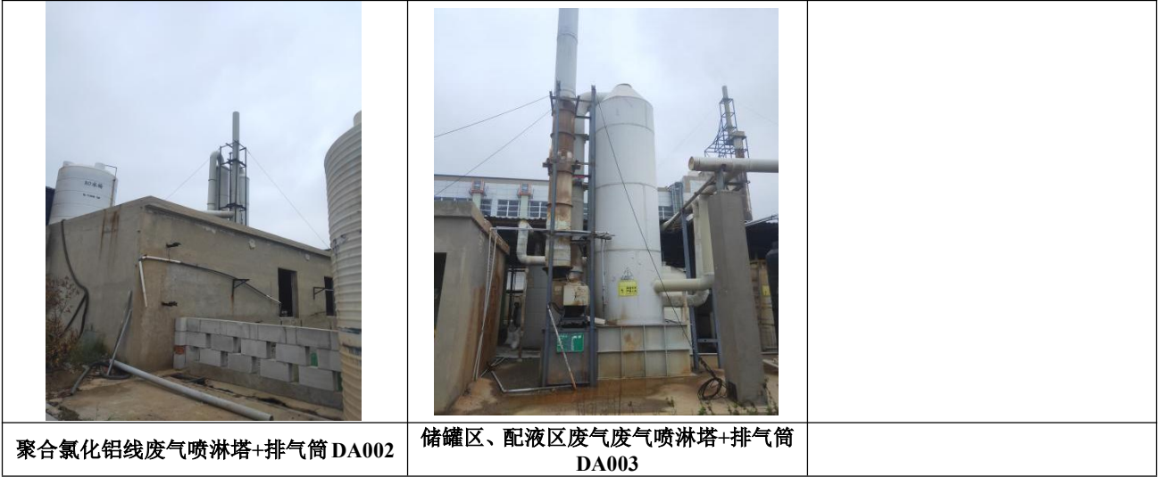
图 4.1-6 项目废气收集处理措施图
