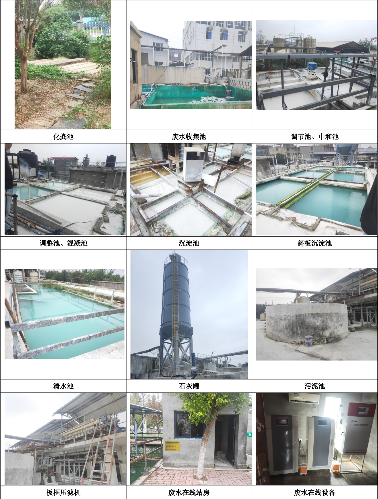
图 4.1-3 项目废水收集处理措施图
