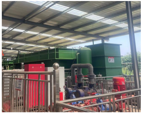
污水处理汽浮及砂滤
