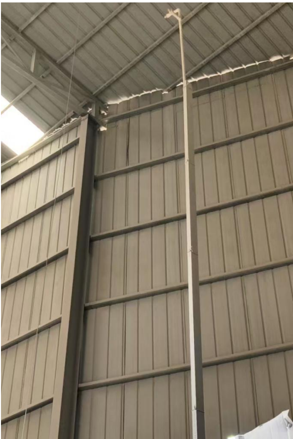
混凝土生产线骨料上料区喷雾降尘
