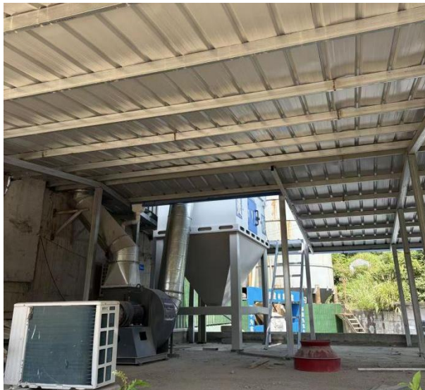
一破、二破工序布袋除尘器
