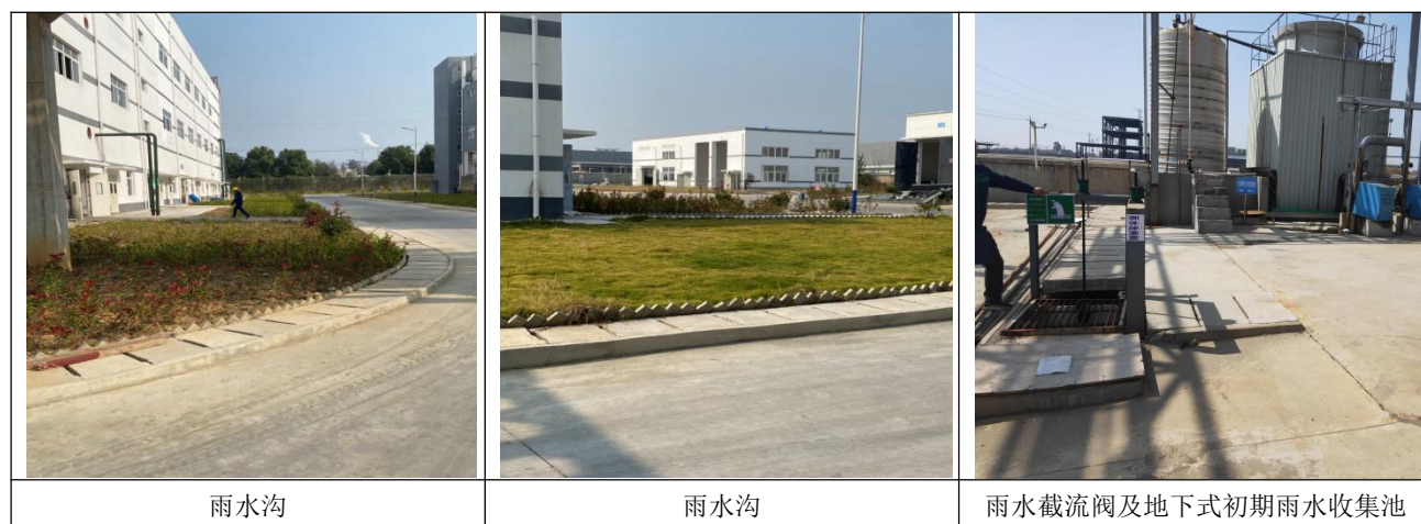
图 4.1-4 厂区初期雨水收集系统图
