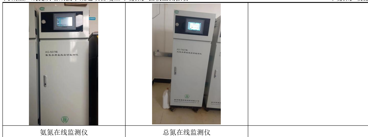
图 4.2-2 排污口规范化设置和在线监测装置图
