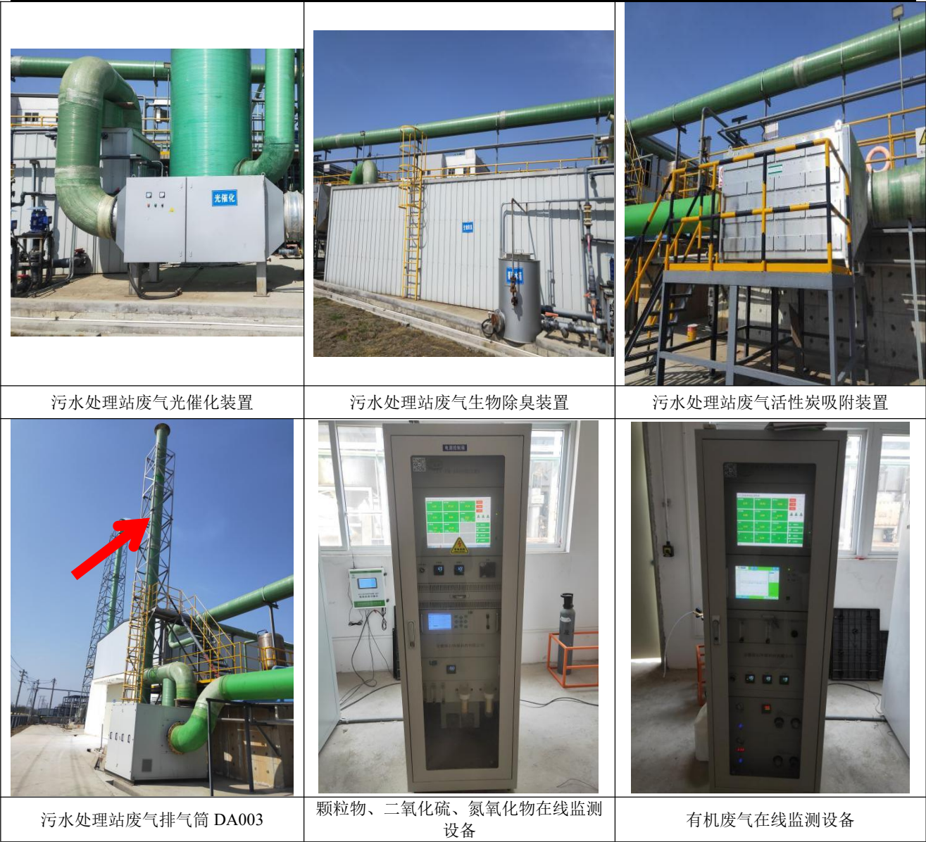
图 4.1-7 项目废气收集处理措施图
