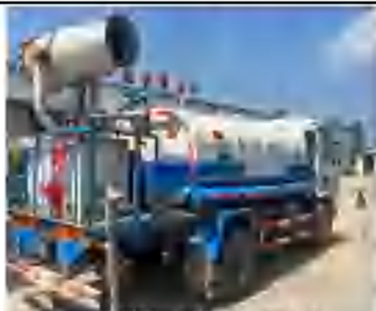
三里畈沿河大道施工洒水车
