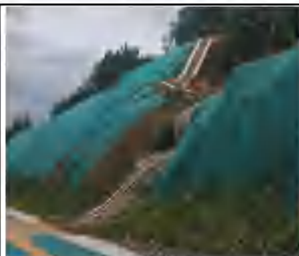
边坡截排水沟
