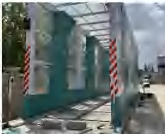
大士阁山谷公园施工清洗设施
