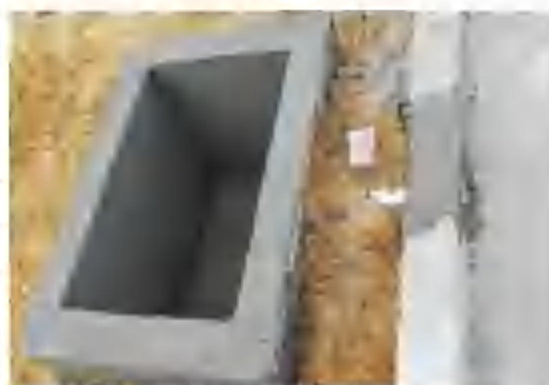
主体工程沉砂池
