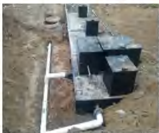
地下一体化污水处理设施（施工前）
