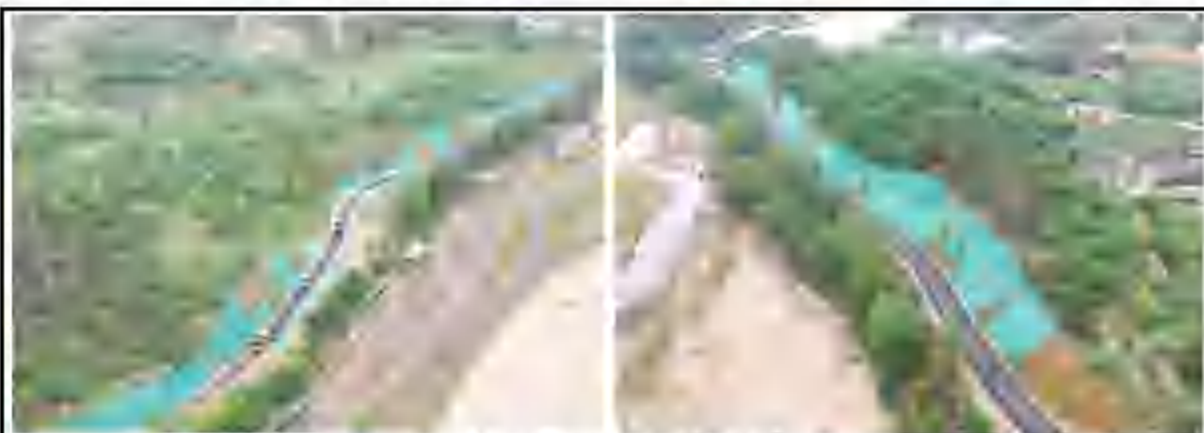
义水河堤防治理情况
