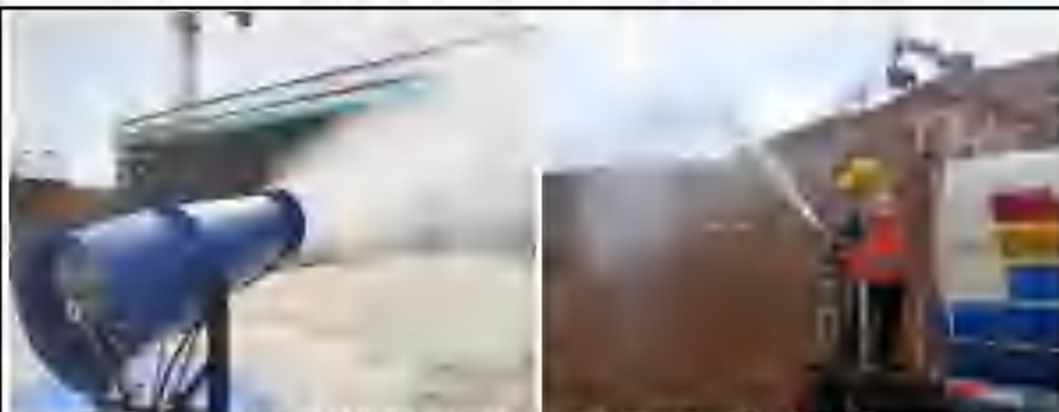
施工期大气污染防治措施（临时苫盖、围挡、喷雾、洒水等措施）
