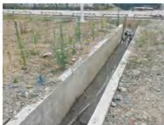
站区外截排水沟
