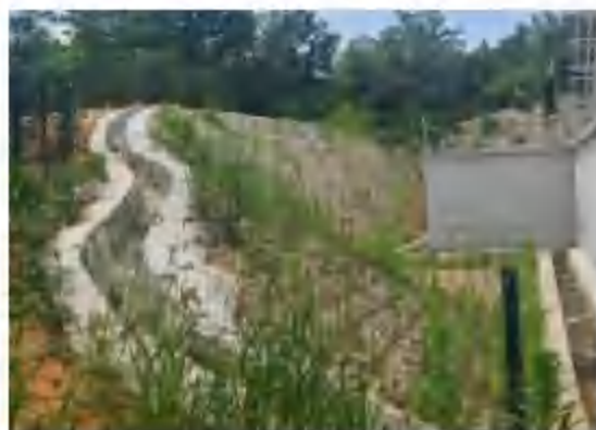
站区外截排水沟
