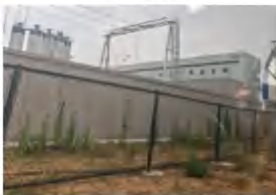
临时围挡措施
