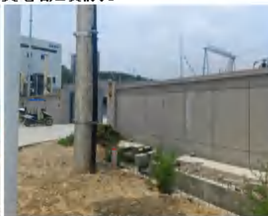
变电站出入口
