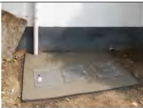
廊道转运站生活废水处理设施（依托）
