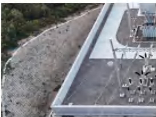
站外边坡防护措施
