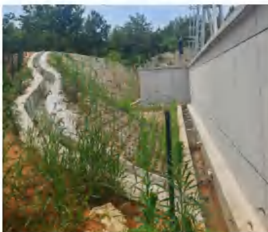
站区周边截排水沟
