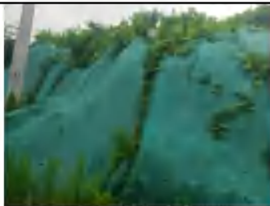
变电站施工期边坡防护措施
