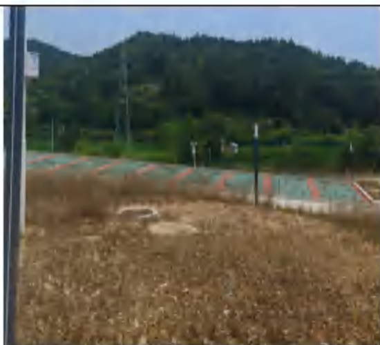
矿山砂石工厂地理一体化污水处理设施
