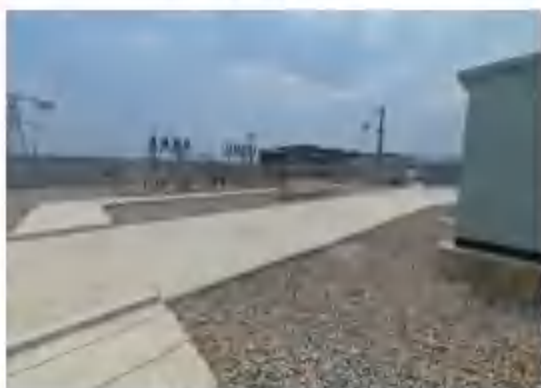
站区内硬化措施
