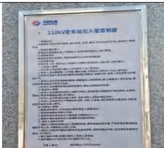
变电站相关管理制度及应急预案上墙
