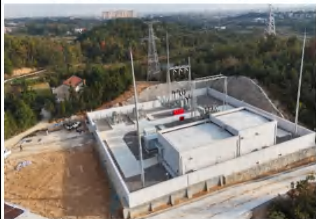
110kV 廊道变电站遥感影像图
