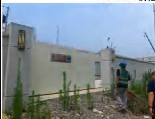
变电站出入口
