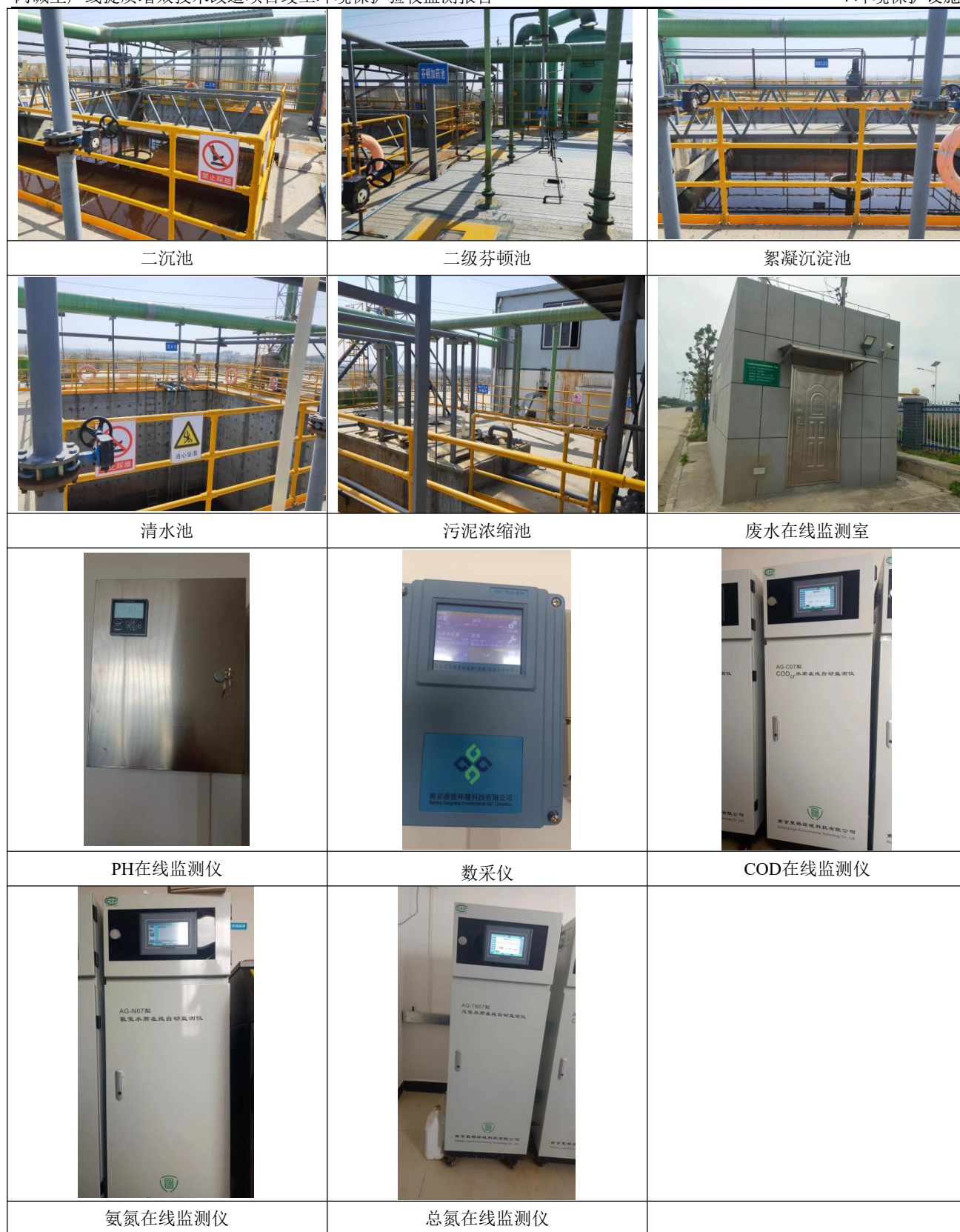
图 4.1-3 项目废水收集处理措施图
