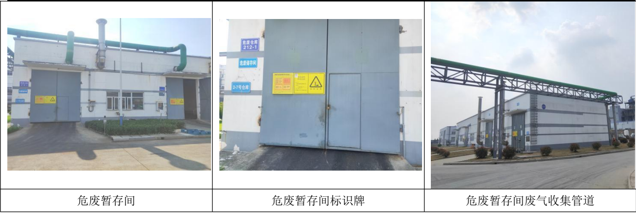
图 4.1-8 厂区危废暂存间建设图
