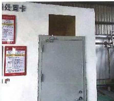
废水在线监测室大门处
