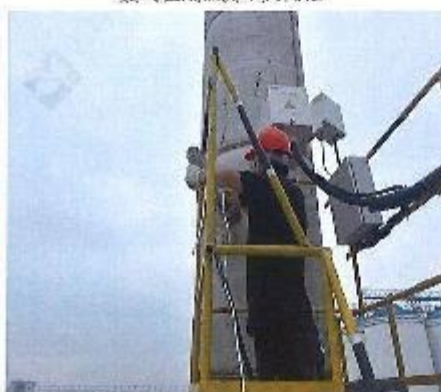
锅炉废气排放口 1#
