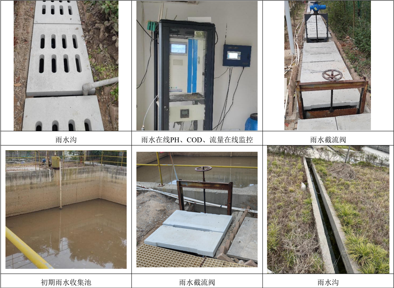
图 4.1-3 厂区初期雨水收集系统图
