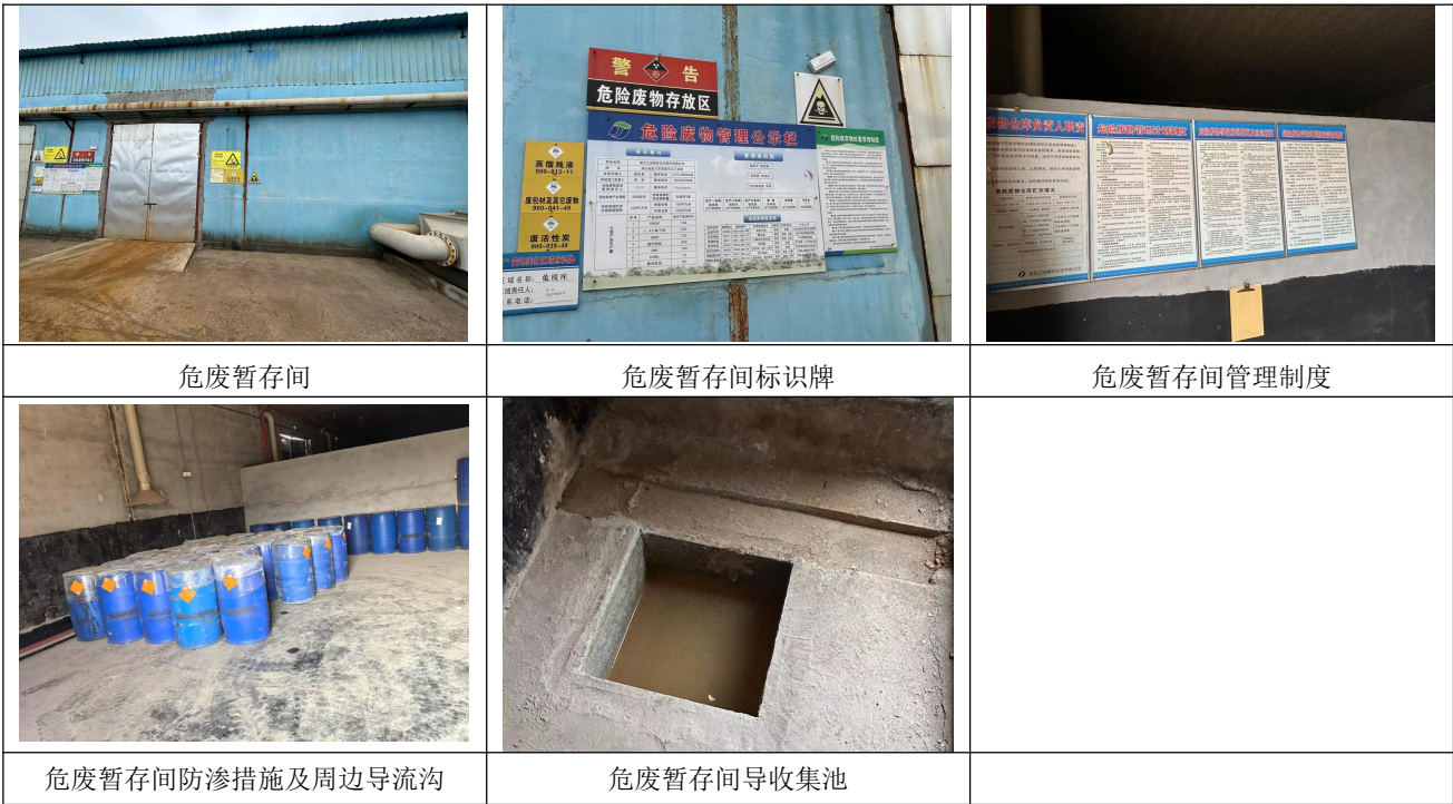
图 4.1-6 厂区危废暂存间建设图
