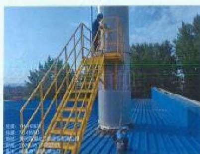
喷漆废气排放筒监测口
