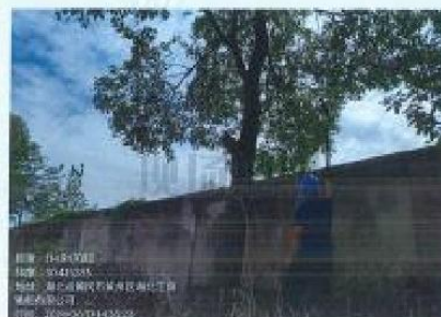
东侧厂界外1m处
