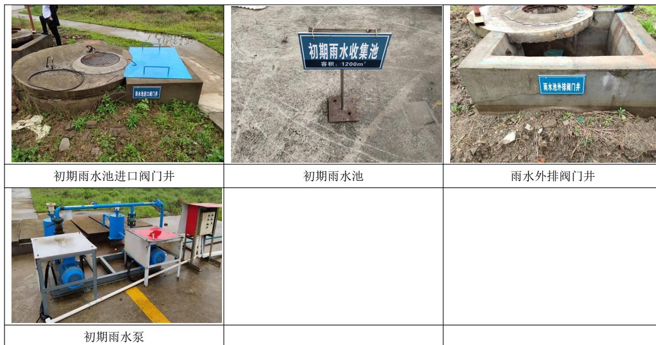
图 4.1-4 厂区初期雨水收集系统图
