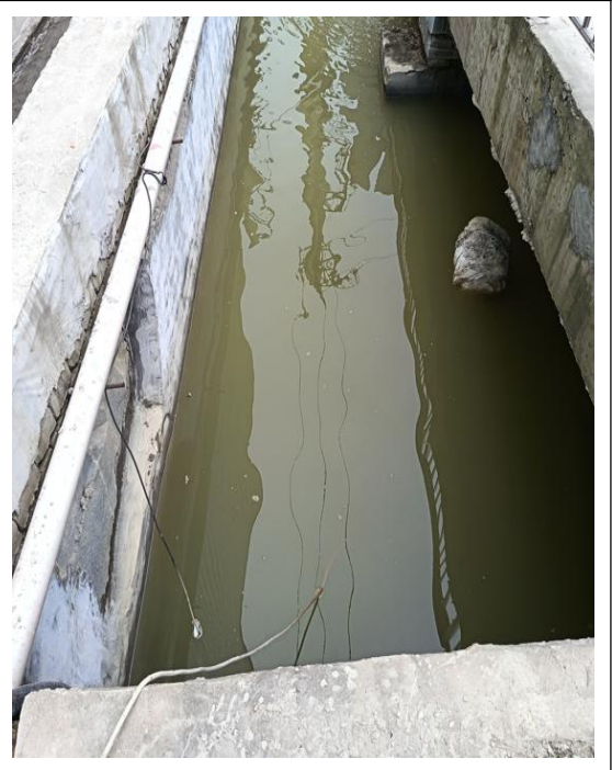
初期雨水收集池
