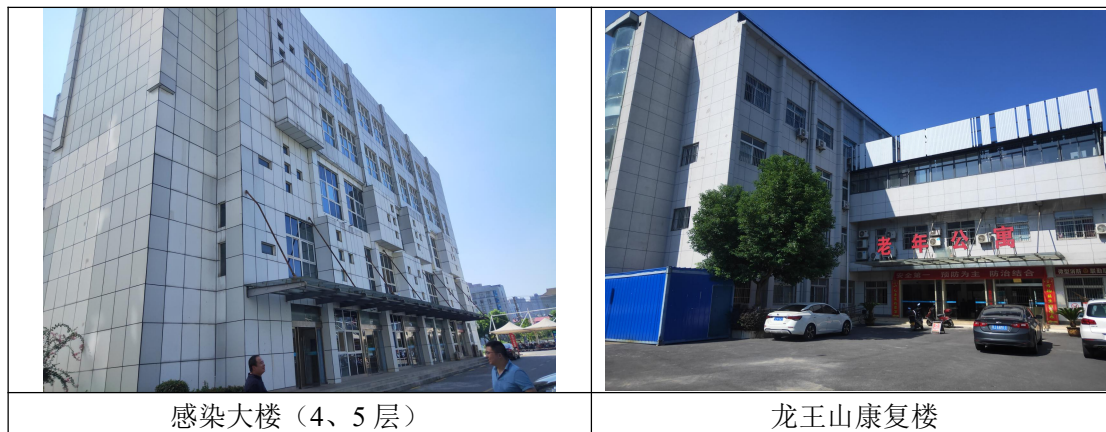
图 2-1 项目现场情况图片
