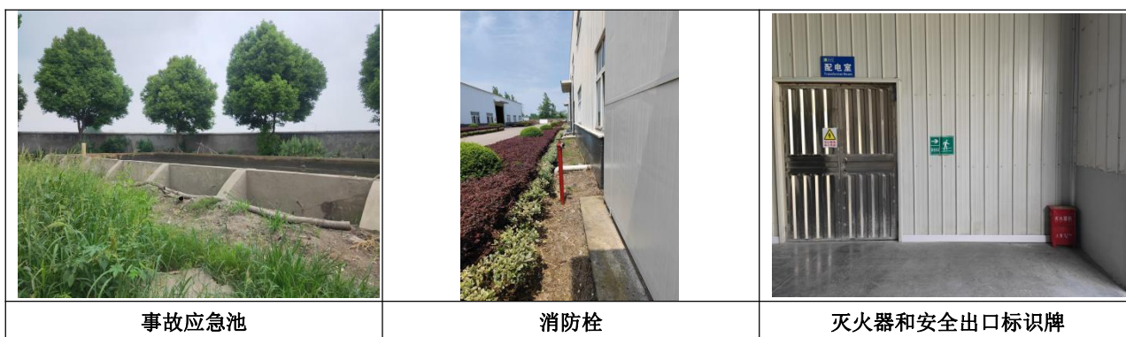
图 4-2-1 项目环境风险应急措施图片
