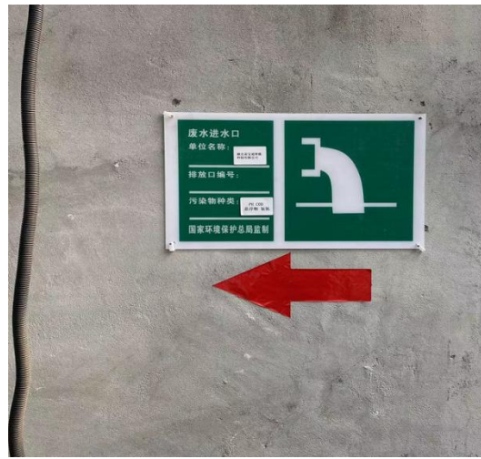
废水进水口标识牌
