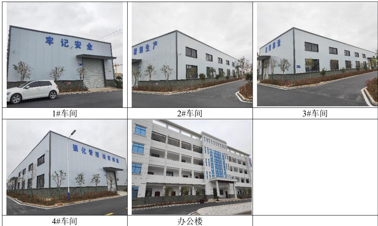
图 2-1 项目现场情况图片
